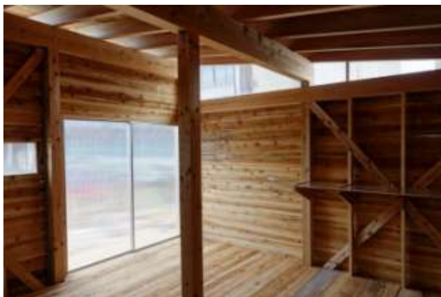
(45)玄関アルミ建具室内より
