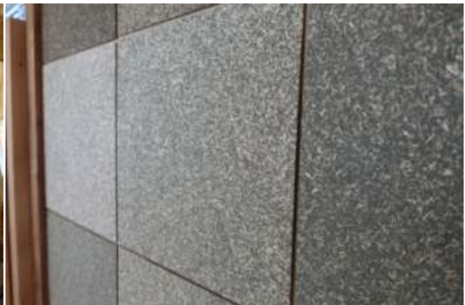
ラワンベニヤ下地に両面テープ+タッカーで固定
