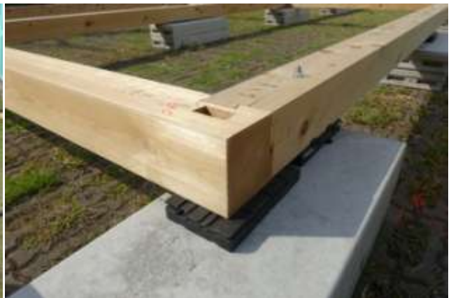
(5) 土台パッキン
