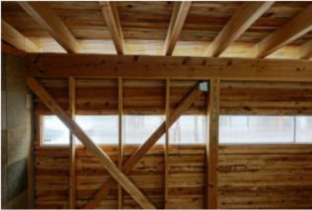
垂木間開口へのツインポリカ板嵌め込み、外壁隙間への目地棒差し込み
