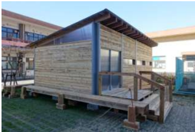
(49)玄関ポーチ階段の手摺設置
