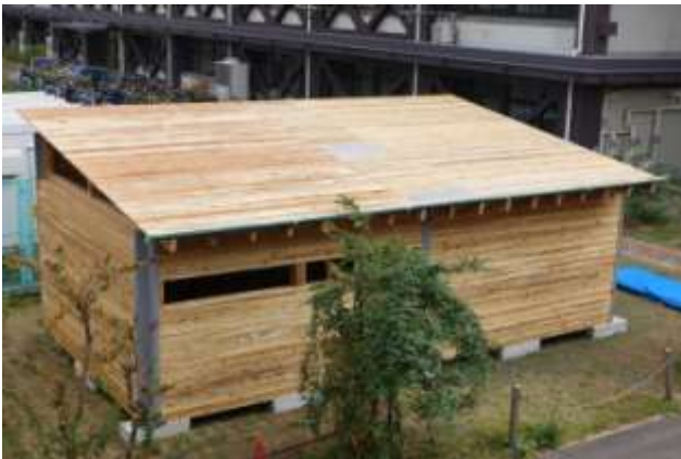
(19) 野地板取り付け完了
