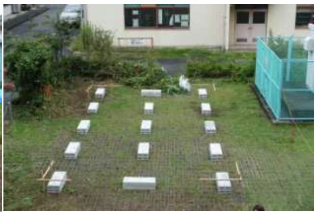
(2) 束石(メッシュ入りコンクリートブロック)設置
