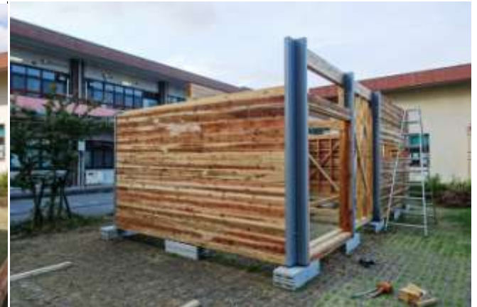
(12)外壁材(杉グリーン材)落とし込み
