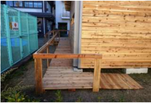
(51)スロープの手摺設置
