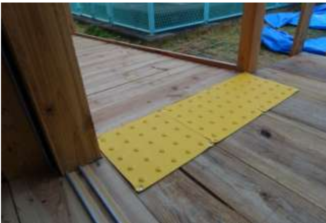
(52)スロープ立ち上り部および点字ブロック設置(下り部)
