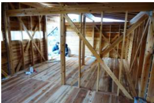
(27)床板貼り付け完了
