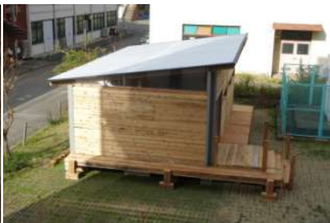
(48)南東上部より見下ろし
