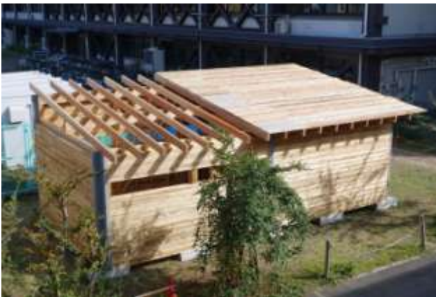
(16) 野地板(杉 \phi 24mm)取り付け
