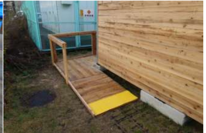
(53)スロープ点字ブロック設置(上り部)
