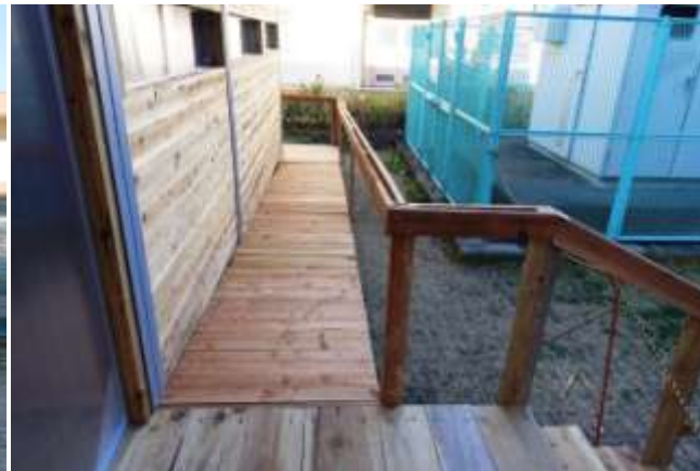
(50)スロープの手摺設置
