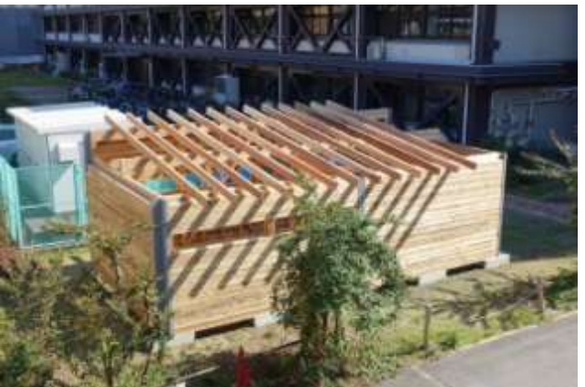
(14)垂木(杉 1 等)設置(垂木 1 本当たりタルキックⅡ×12 本) ※くら金物の代替
