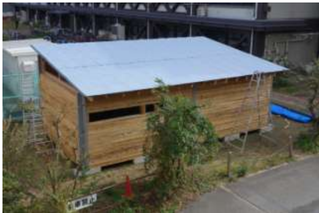
(21)ガルバリウム鋼板貼り付け
