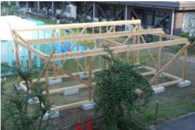
(6) 柱・梁(杉 1 等)の建て方
