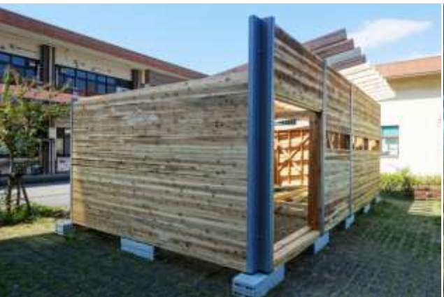
(13)外壁落とし込み完了
