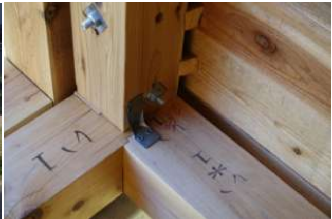
(17) 土台・柱接合金物(4.2kN)
