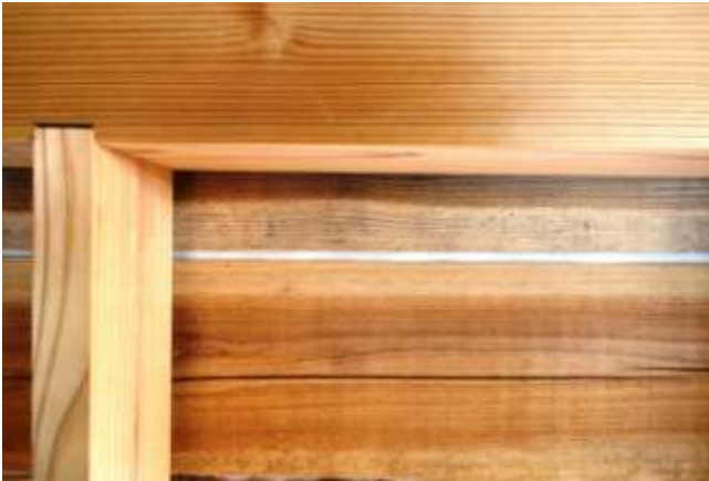
外壁隙間への目地棒差し込み
