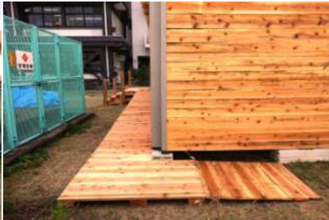
(44)スロープ床材(杉板)
