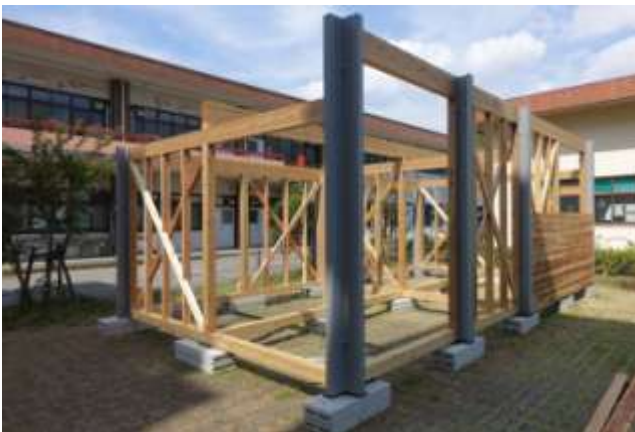
(11)外壁材落とし込みガイド金物(西側)設置
