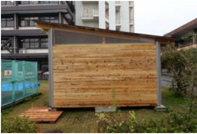
(36)妻側ハイサイドライト(北側)の仮設置 平成 27 年 11 月 24 日
