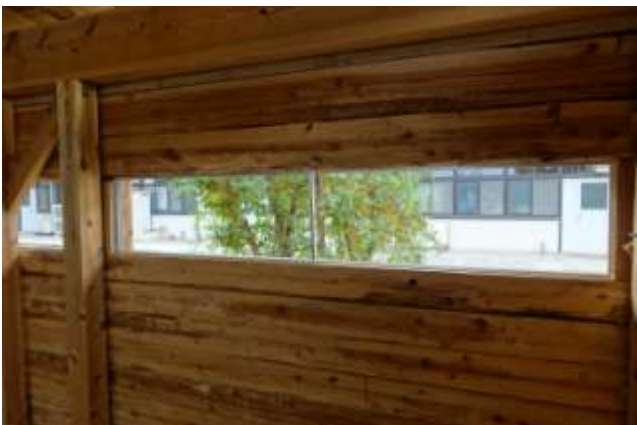
(26)アルミ窓枠取り付け
