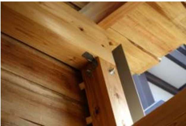
(18) 柱・梁接合金物(4.2kN)
