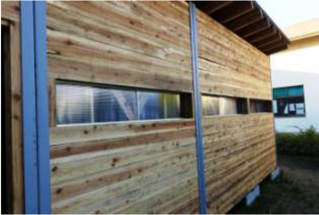
(29)窓建具設置完了 平成 27 年 11 月 10 日
