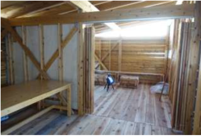
茶がらボード設置完了(裏)下地ラワンベニア表し
