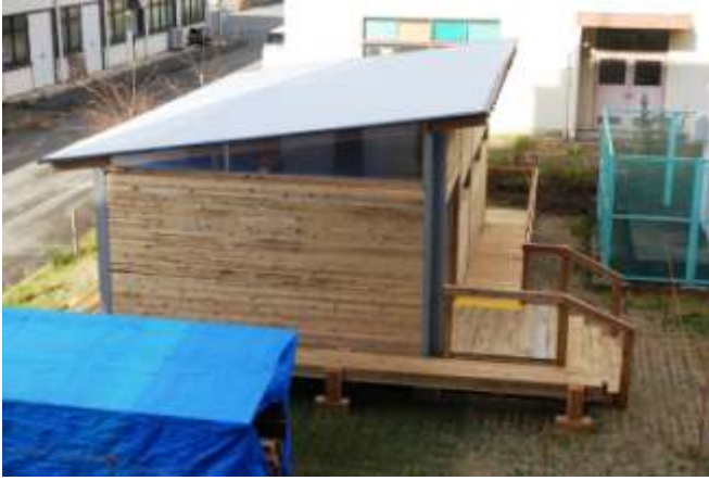
(57)南東より見下ろし
