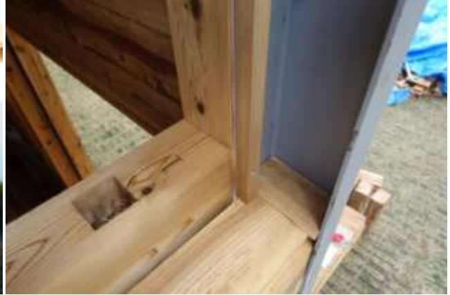
(30)妻側ハイサイドライトのアルミ枠取付準備
