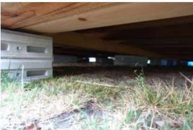
(56)開放された床下(常時点検可能)
