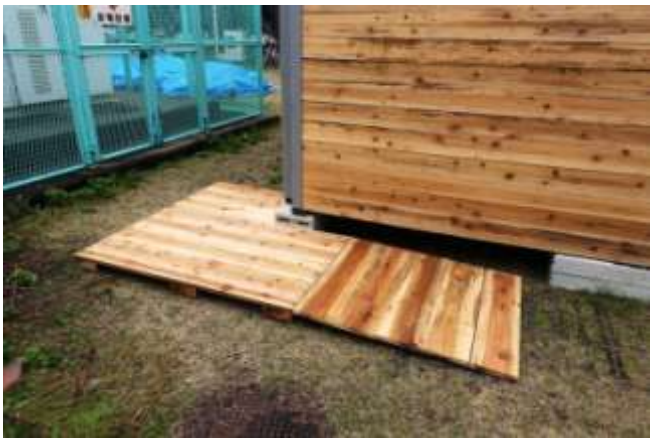
(40)スロープ登り始め部分設置
