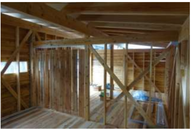
(41)室内木製建具(木製カーテン)設置(閉じた状態)
