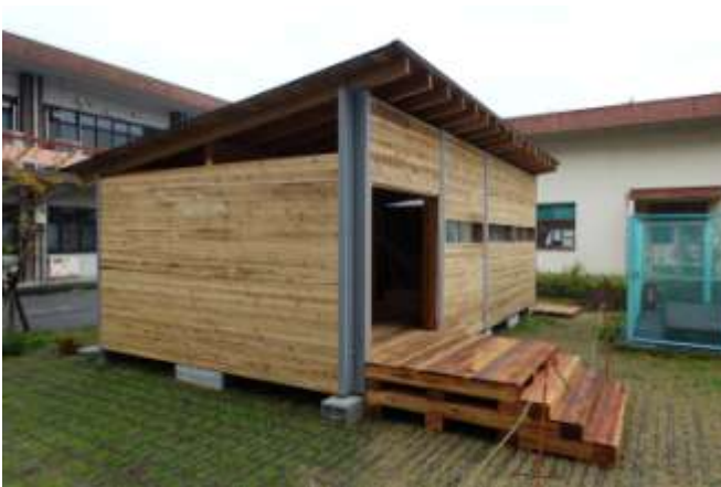
(34)玄関ポーチ階段の段板取付
