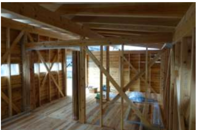
(42)室内木製建具(開いた状態)
