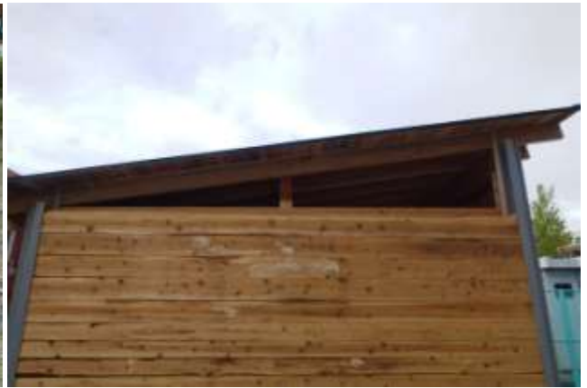
(32)妻側ハイサイドライトのアルミ枠取付
