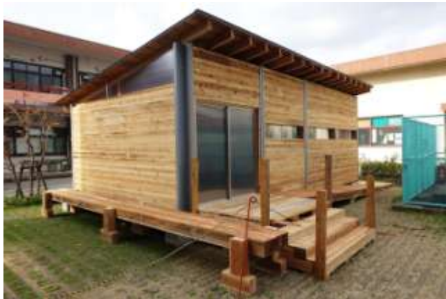
(43)スロープ床材・玄関アルミ建具設置、階段手摺着手
