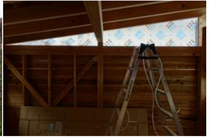
(37)妻側ハイサイドライト(北側)内部より
