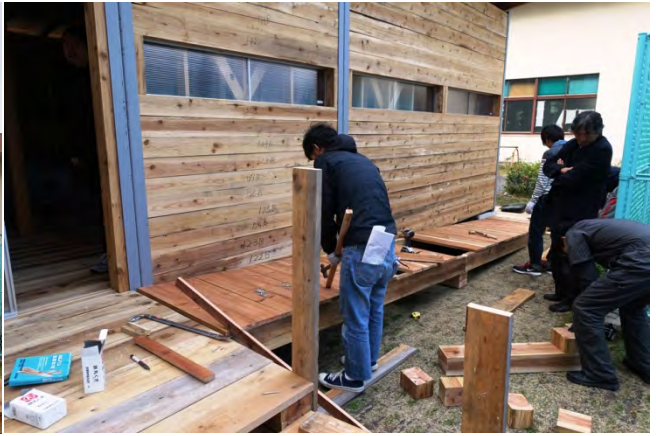
玄関ポーチ・スロープ設置
