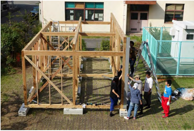
間柱・筋違、外壁取付け用コ字型金物設置
