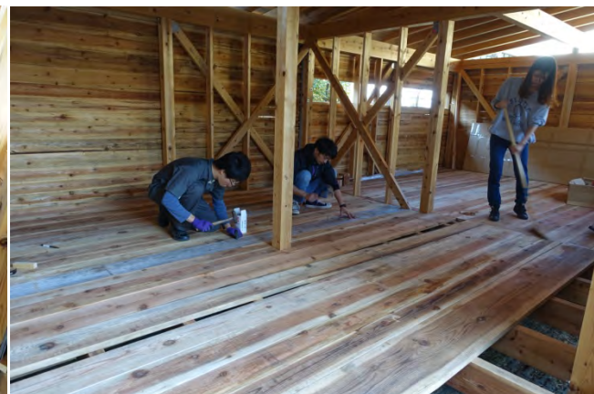
床材貼り付け
