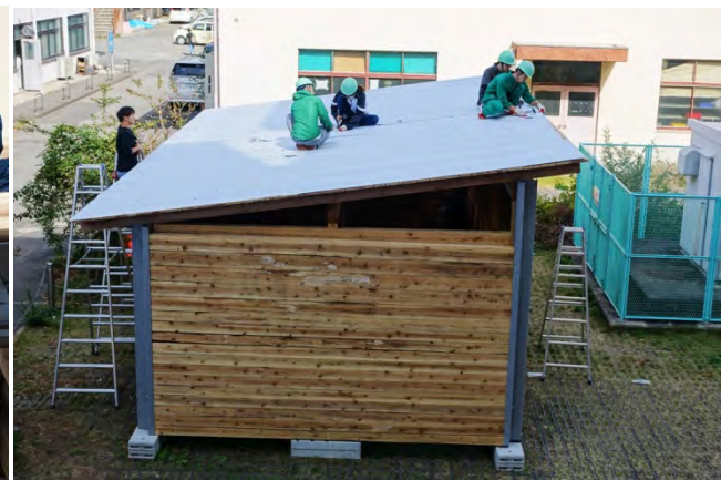
屋根材(ガルバリウム鋼板波板)打ちつけ
