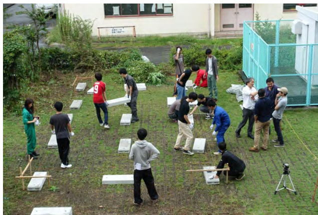
東石(自販機のメッシュ入り基礎ブロック)設置
