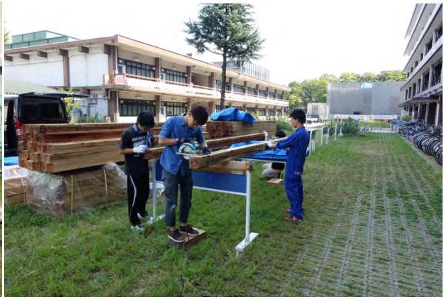
外壁用の杉角材切り出し、含水率測定
