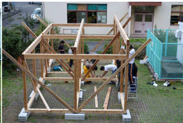
土台設置、柱・梁の建て方
