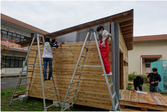
アルミチャンネル+ツインポリカポネート板による開口部
