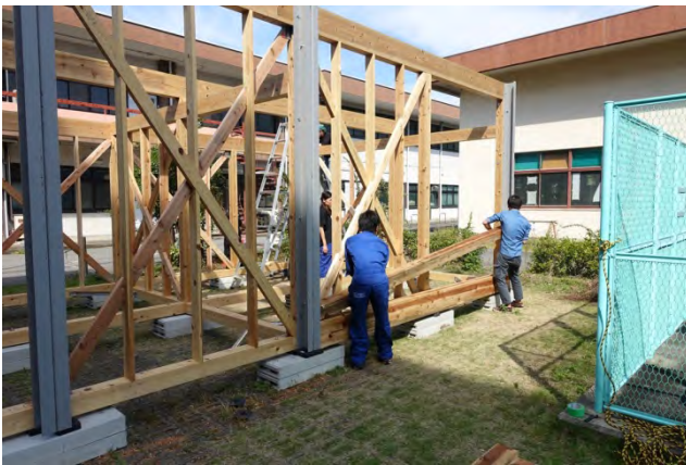
外壁杉角材落し込み(下部)
