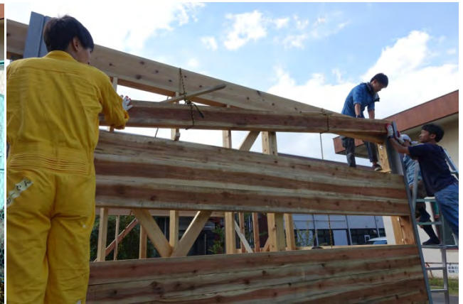
上部はロープで吊上げ(大工の施工指導はここまで)
