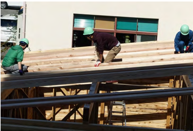
垂木設置(これ以降は学生のみで施工)
